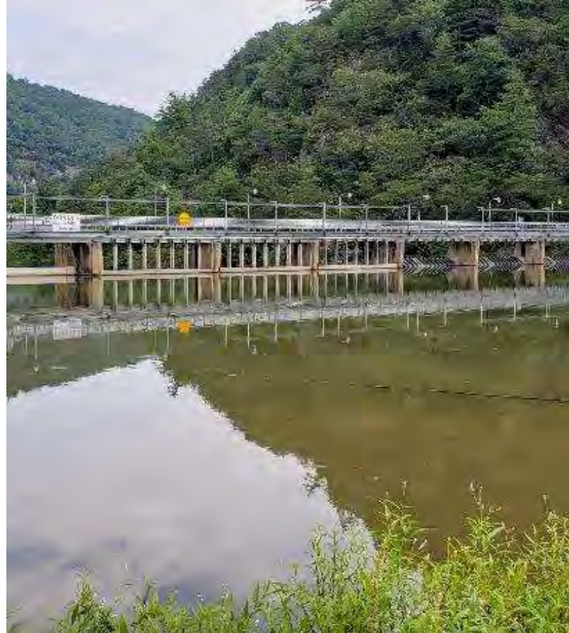
Byllesby Forebay and Spillway 9.9.2020
